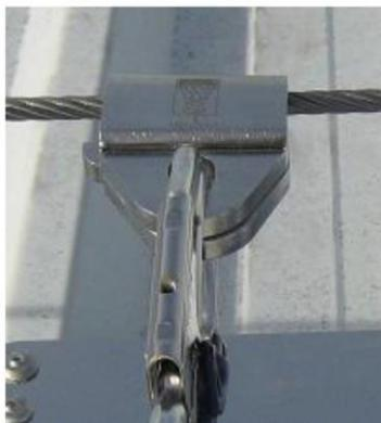
Colocar el conector, introduciéndolo por el orificio que conecta las dos placas del mismo
